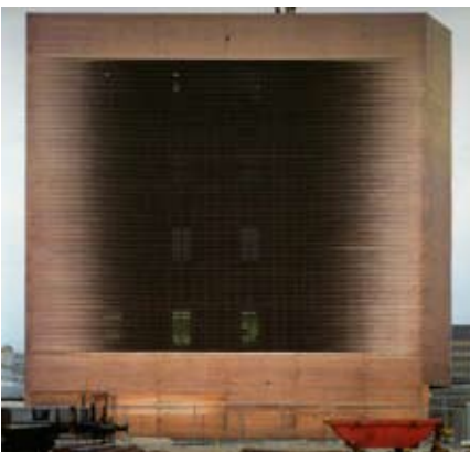
Cabina di controllo, Basilea 1988-95, J. Herzog & P. de Meuron
